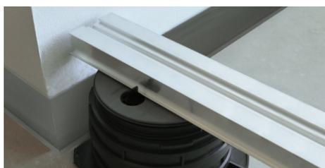
26. Insérer la traverse entre les ailettes SUPA4 des supports périphériques le long du mur.
