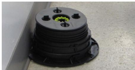
4. Assembler le support et le placer avec le côté découpé appuyé contre le mur.
