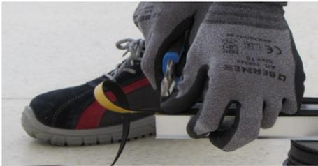
35. Couper la bande à l'extrémité de la traverse à l'aide d'un cutter.
