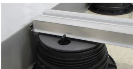
15. Insérer la traverse entre les ailettes SUPA4 des supports périphériques le long du mur.
