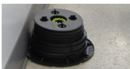
5. Assembler le support et le placer avec le côté découpé appuyé contre le mur.
