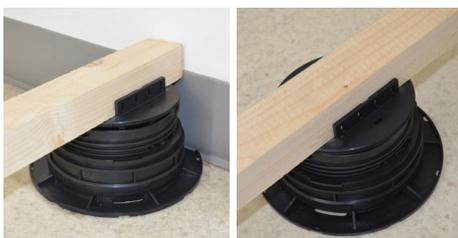
12. Colocar la viga de madera apoyada en la aleta SUPAVV.
