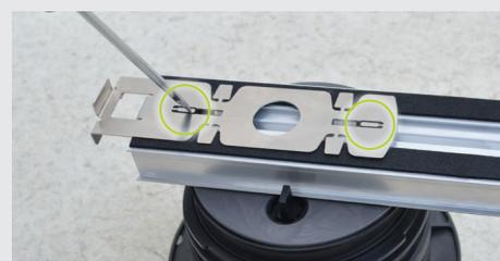
2. Encajar el clip a la viga de metal doblando las pestañas hacia abajo con la ayuda de un destornillador.
