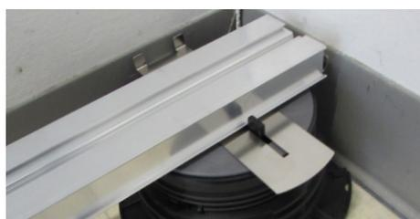
7. Insérer la traverse entre les ailettes SUPAJ du support d'angle.
