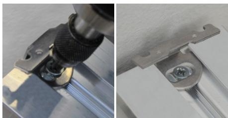
18. Fijar el clip en el rastrel con un destornillador adecuado.
