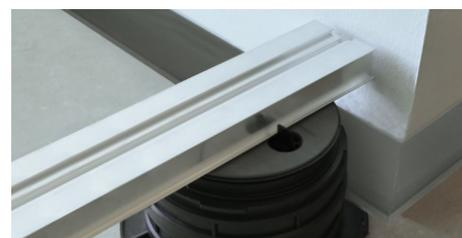
28. Insérer la traverse entre les ailettes SUPA4 des supports périphériques le long du mur.
