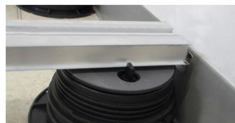
17. Insérer la traverse entre les ailettes SUPA4 des supports périphériques le long du mur.
