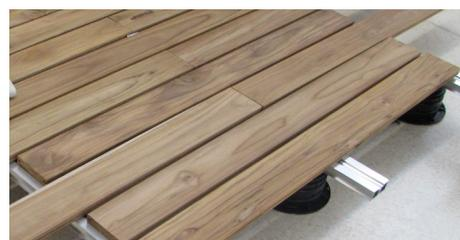
22. Colocar todos los listones de madera encajando su ranura en el clip SUPCLIP.
