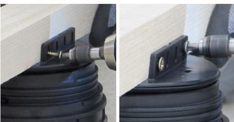
13. Atornillar la viga en el soporte a través de las correspondientes ranuras (utilizar un destornillador).
