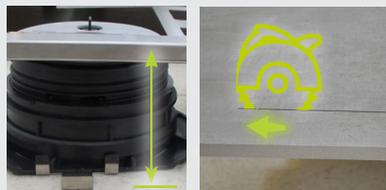
D-4. Corte la baldosa a la medida correspondiente entre el perfil BSJ y el clip base SUPACLPB.
