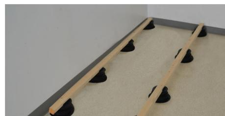
14. Comprobar que la viga esté firmemente fijada en todos los soportes.
