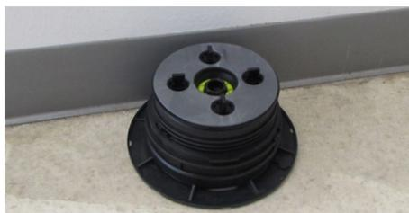
11. Assembler le support et le placer avec le côté découpé appuyé contre le mur.
