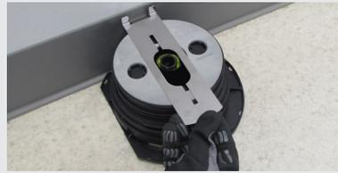
D-2. Sitúe el clip distanciador SUPACLPP sobre el cabezal del soporte.
