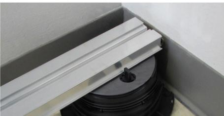
5. Insérer la traverse entre les ailettes SUPA4 des supports d'angle.
