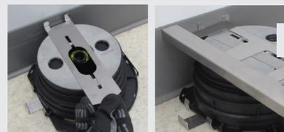
D-3. Coloque el clip distanciador SUPACLPP y el perfil BSJ sobre el cabezal del soporte.
