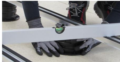
36. Vérifier que l'installation est de niveau. Si ce n'est pas le cas, modifier la hauteur des supports.
