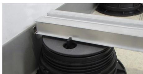
12. Insérer la traverse entre les ailettes SUPA4 des supports périphériques le long du mur.
