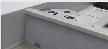
D-5. Encaje la baldosa cortada entre el perfil BSJ y el clip SUPACLPB.
