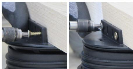
20.\* Atornillar la viga en el soporte a través de las correspondientes ranuras (utilizar un destornillador).
