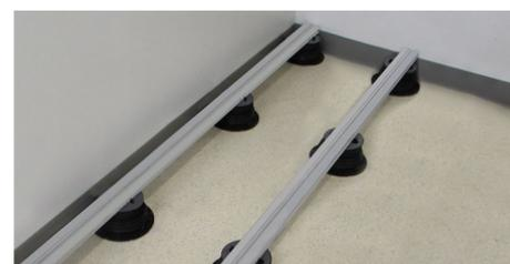
14. Comprobar que el rastrel esté firmemente enganchado a todos los soportes.
