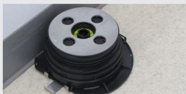
D-2. Coloque el soporte con un lado cortado hacia la pared y el otro hacia el exterior.
