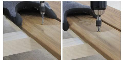
24. Atornillar el listón de madera en la viga que se encuentra debajo con un destornillador adecuado.
