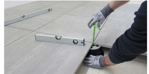
17. En el caso de el pavimento no sea lineal, ajuste la altura con la llave SUPAK.
