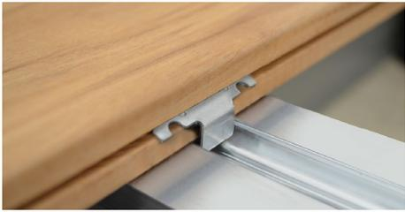
20. Placer une cale SUPCLIP pour bloquer les lames.
