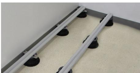
29. Comprobar que el rastrel esté firmemente enganchado a todos los soportes.
