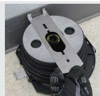
D-3. Sitúe el clip distanciador SUPACLPT perpendicular hacia la pared. Colocar sobre el SUPACLPB.
