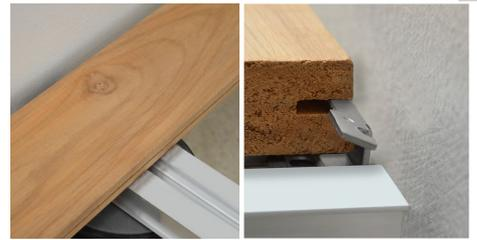
19. Poser la première rangée de lames de bois en insérant sa rainure dans la cale SUPCLIP.
