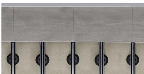
39. Placer la première rangée de carrelages perpendiculairement à l'orientation des traverses.
