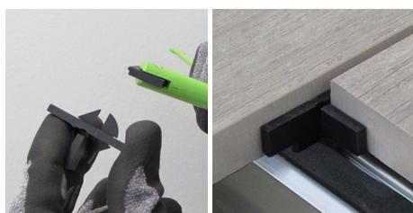
40. Insérer les cales d'écartement SUPD (en enlevant les ailettes inutiles) dans la rainure prévue à cet effet sur la traverse à l'endroit où il faut poser le carrelage en quinconce de la rangée suivante.
