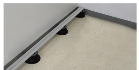
7. Comprobar que el rastrel esté firmemente enganchado a todos los soportes.
