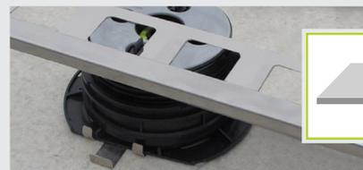
E-3. Sitúe el perfil BSJ sobre el cabezal del soporte.
