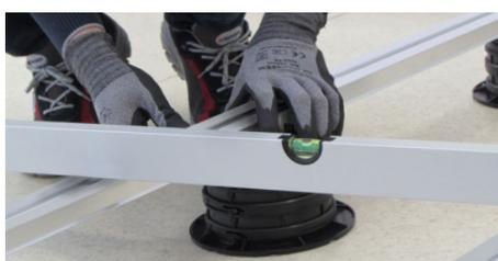
16. Vérifier que l'installation est de niveau. Si ce n'est pas le cas, modifier la hauteur des supports.
