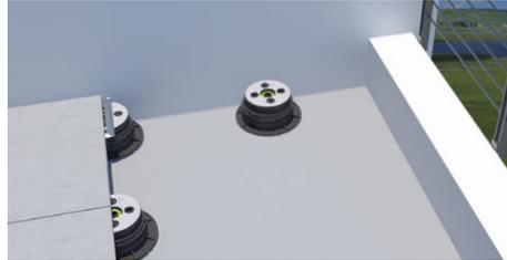
2. Colocar el soporte con el lado cortado en contacto con la pared.
