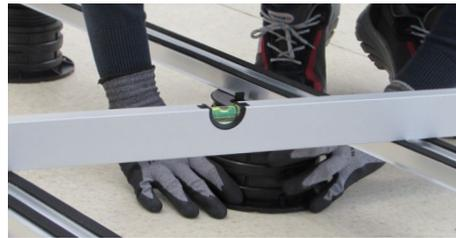
36. Comprobar que la colocación esté nivelada. En caso contrario, modificar la altura de los soportes.
