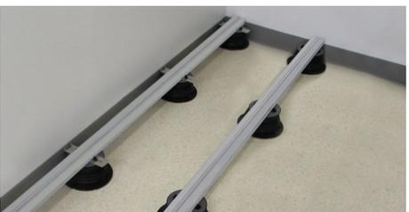
18. Comprobar que el rastrel esté firmemente enganchado a todos los soportes.
