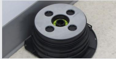
D-1. Coloque el soporte con un lado cortado hacia la pared y el otro hacia el exterior.
